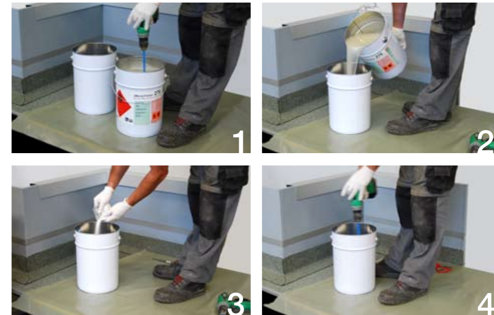
Bild 1: Flüssigkomponente im Gebinde gründlich aufrühren.
