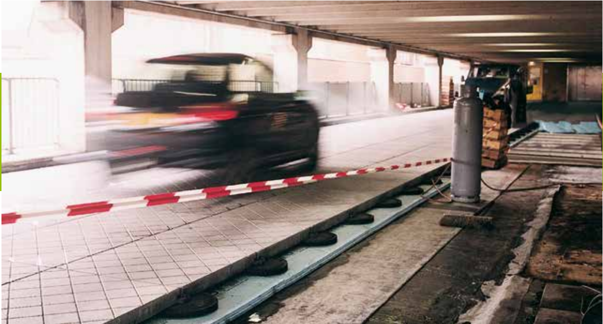
Während der Renovierungsarbeiten kann Mann das Pardak® 90-System direkt befahren
